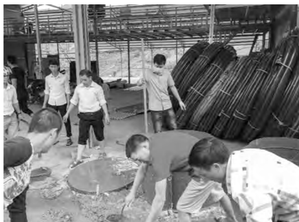
Cán bộ Trung tâm Y tế huyện Tam Đường tập huấn cho người dân tại xã Bản Giang xây dựng nhà tiêu giá rẻ bằng ống bê tông
